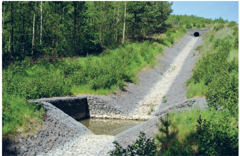
Siatkowo-kamienne umocnienie sprowadzenia wód. Na terenie zwalowiska zewnętrznego funkcjonuje łącznie 12,5 km sprowadzeń różnego typu.
