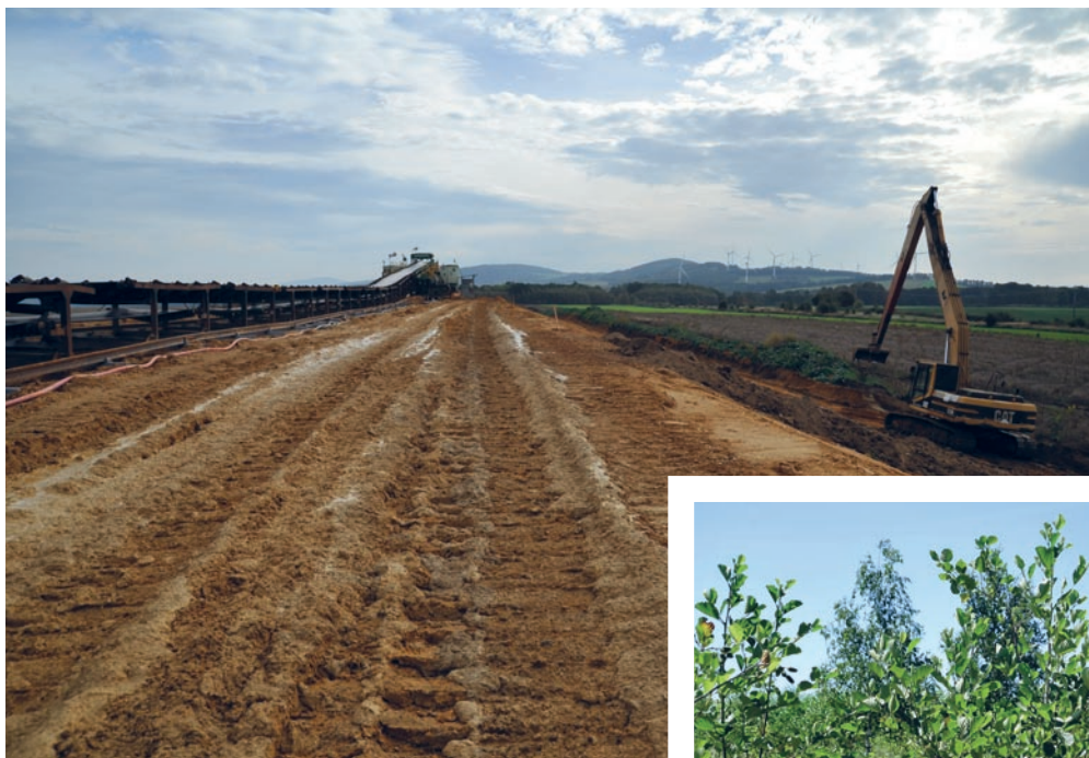
Budowa wału ziemnego.
