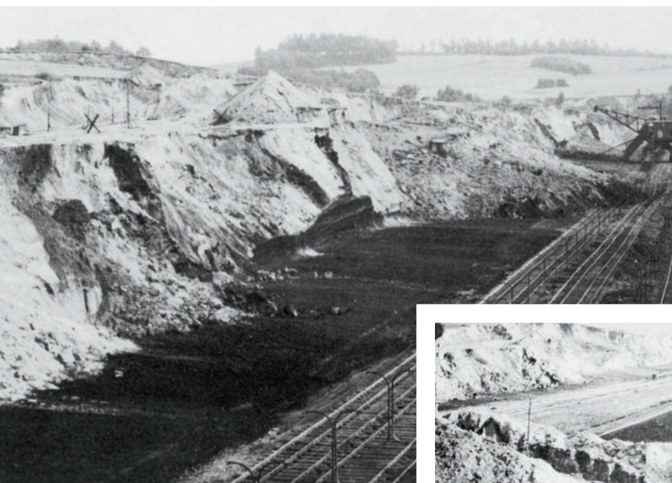
Praca koparki nr 9 (szynowej) na nadkładzie. Widać jak płytko był węgiel. Rok 1926.
