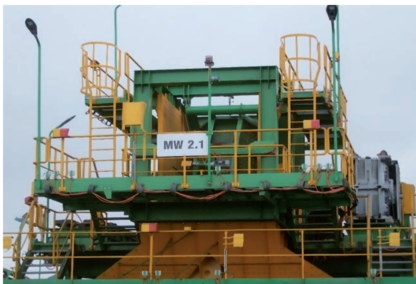
Rys. 1. Fragment przenośnika magistrali węglowej MW-2.1 (KWB Turów).
