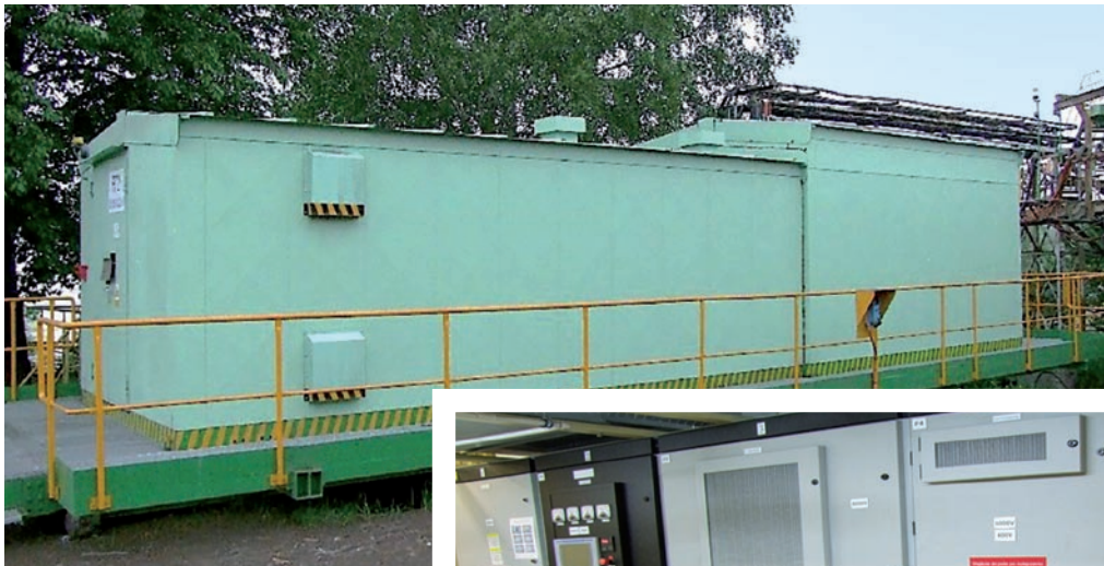
Rys. 2. Kontener elektryczny z zabudowanym falownikiem 6 kV.
