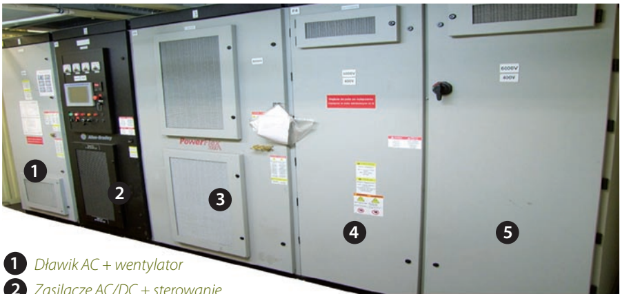
Rys. 2. Kontener elektryczny z zabudowanym falownikiem 6 kV.
