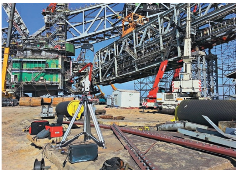
Fot. 5. Pomiar szyny bocznego prowadzenia mostu podawarki SchRs-4000.37,5.
