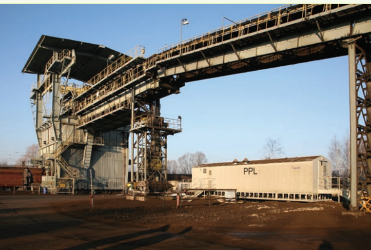
Lubstowska załadownia po modernizacji.
