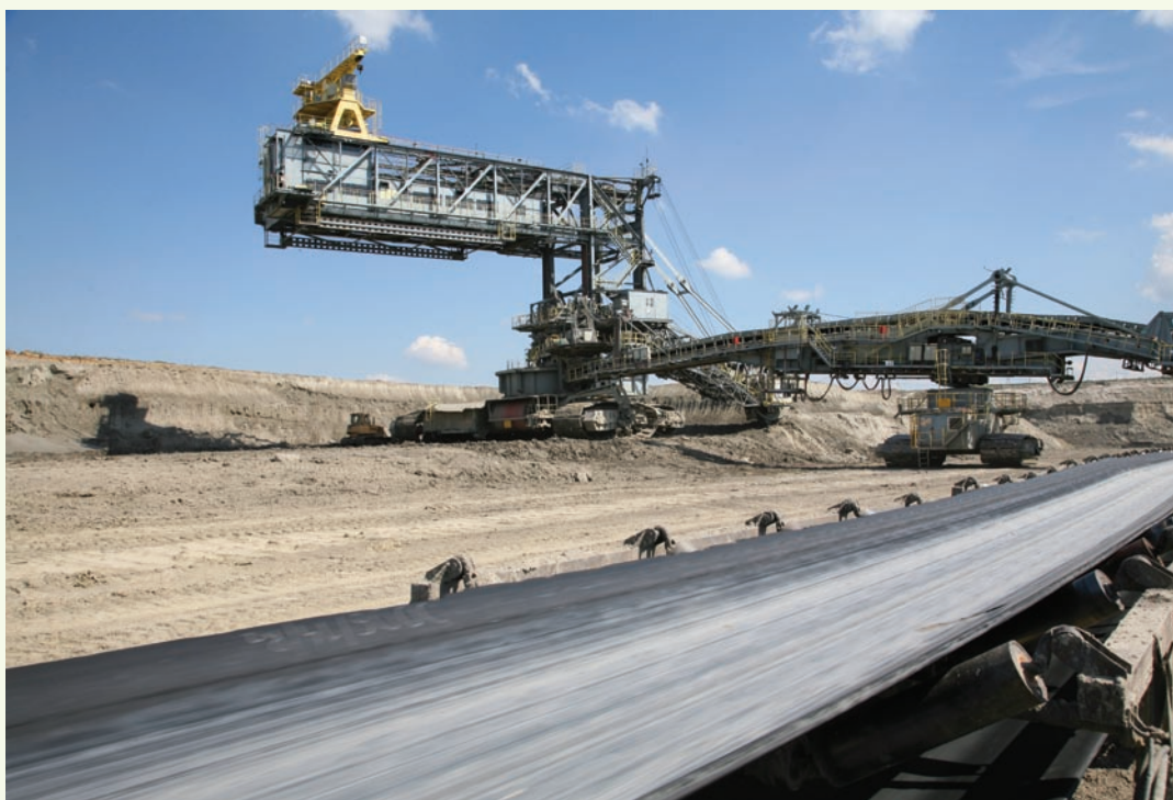
Koparka SRs-1200 podczas budowy pochylni pod przenośnik TP-21.
