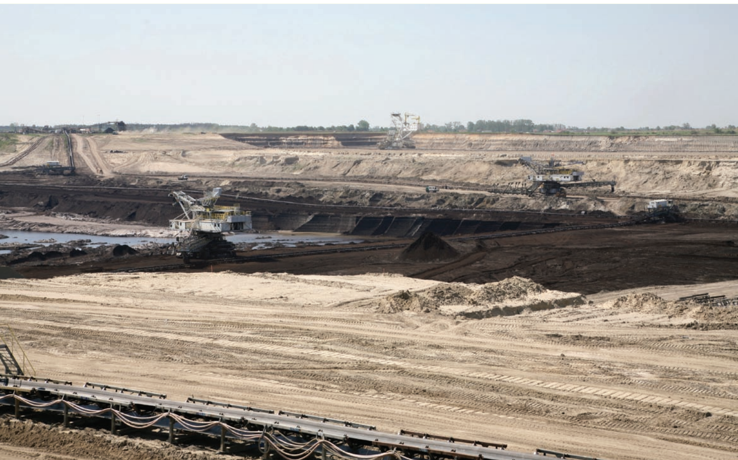
Odkrywka „Tomislawice” po przebudowie – widać szeroką pochylnię główną i krawędź wejścia w zatokę południowo-zachodnią.
