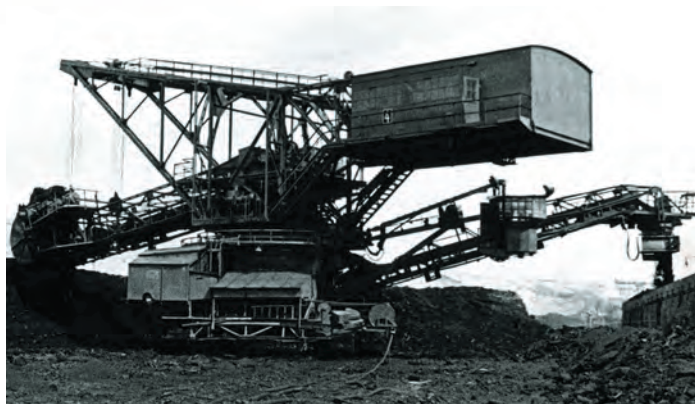
Odkrywka „Gosławice” na przełomie lat 1950-60. Koparka SchRs-315 to jedna z dwóch pierwszych maszyn tego typu, wprowadzonych do kopalni Konin. Jedna z nich była wykorzystywana do urabiania węgla, druga do zdejmowania nadkładu.
