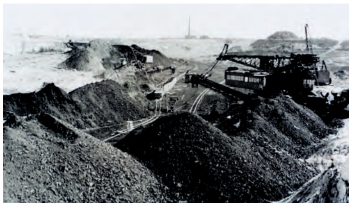
Hały z węglem na odkrywce „Gosławice”. Z prawej widoczna koparka SchRs-315, w środku skład węglowy. Przewóz węgla odbywał się wówczas za pomocą transportu kolejowego. Składy wagonów ciągnęły elektrowozy typu LEW 75.
