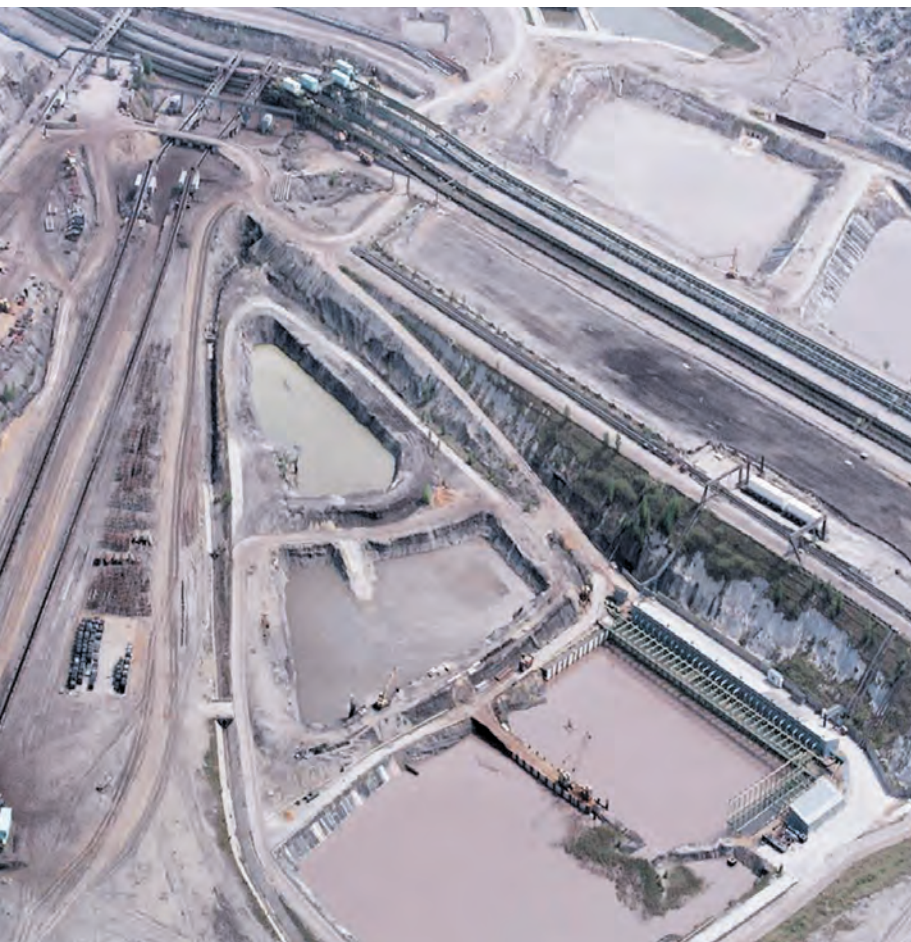
Fot. 9. Pompownia TII/4 – jedna z trzech głównych pompowni zlokalizowana w części wschodniej odkrywki KWB Turów o wydajności 272,8 m 3 /min.
