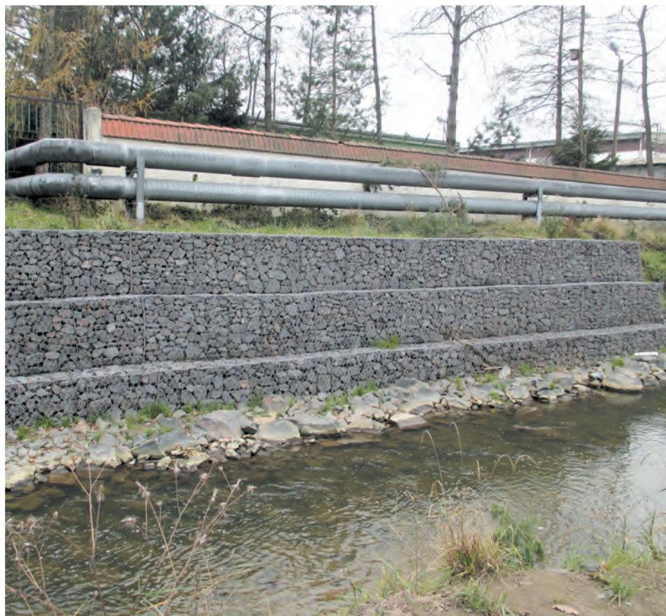
Fot. 8. Koryto rzeki Miedzianki – dodatkowe wzmocnienie brzegu.
