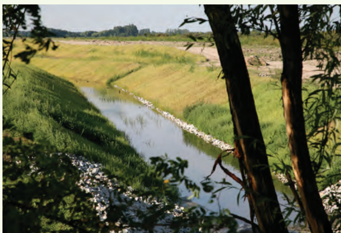
Odtworzone koryto rzeki od strony przepompowni SK-3.
