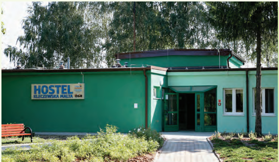
Zielony budynek dawnej dyspozytorni harmonizuje z otoczeniem.
