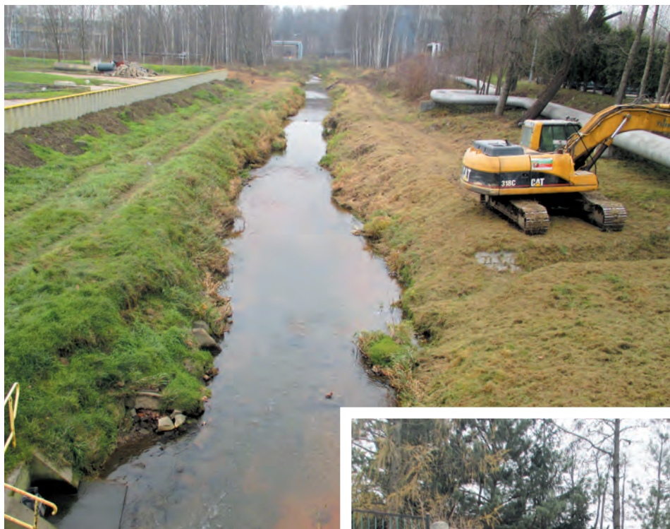
Fot. 7. Uporządkowane koryto rzeki Miedzianki oraz wykonana w 2013 r. ścianka szczelna z pali Larsena.
