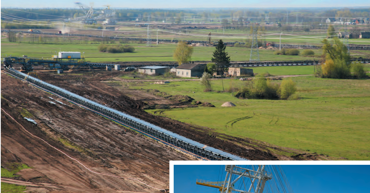
Pierwszy układ przenośników widoczny ze zwałowarki, w tle koparka KWK-1500s.
