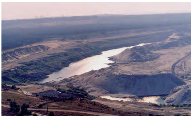
Rys. 6. Kopalnia Adamów – odkrywka Bogdałów w trakcie eksploatacji (1992 r.). [3]
