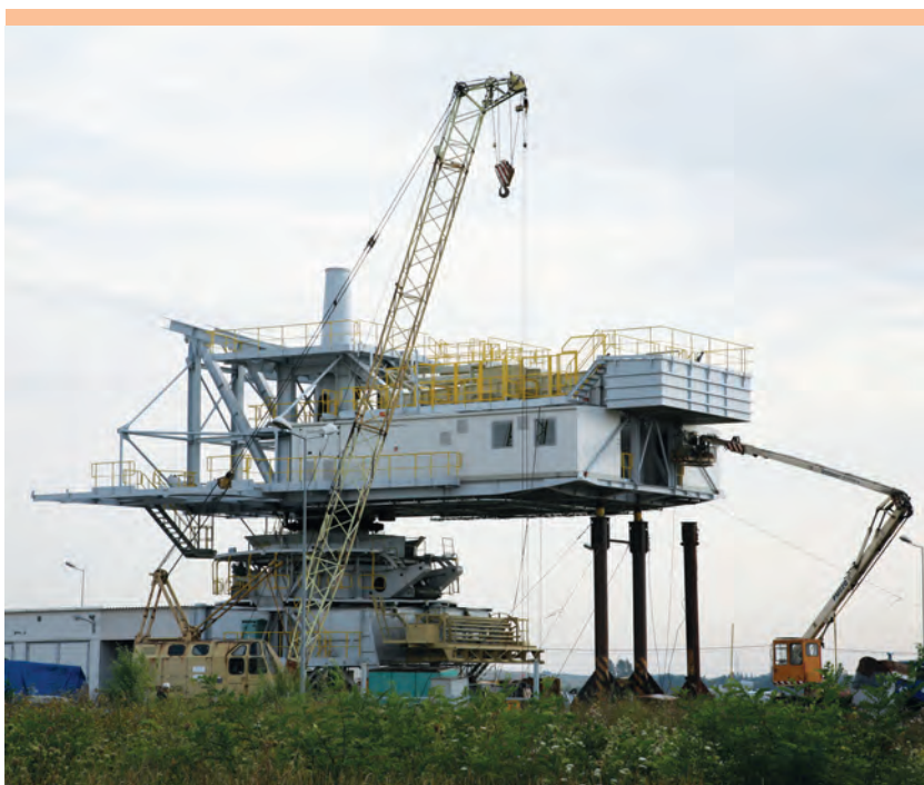
Koparka Rs-560 w trakcie przebudowy.
