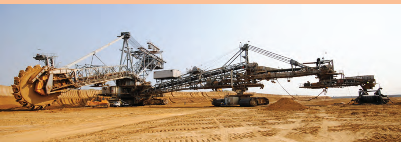
Rys. 4. Koparka SRs-2000 – odkrywka Drmno.
