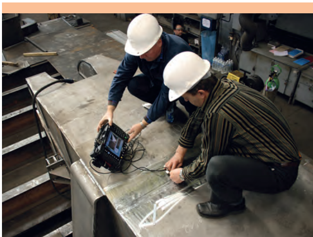
Badanie defektoskopowe złączy spawanych w konstrukcji dźwigara – Dariusz Bonowicz, sztygar zmianowy, Mirosław Rusiecki, pomiarowy na odkrywce.
