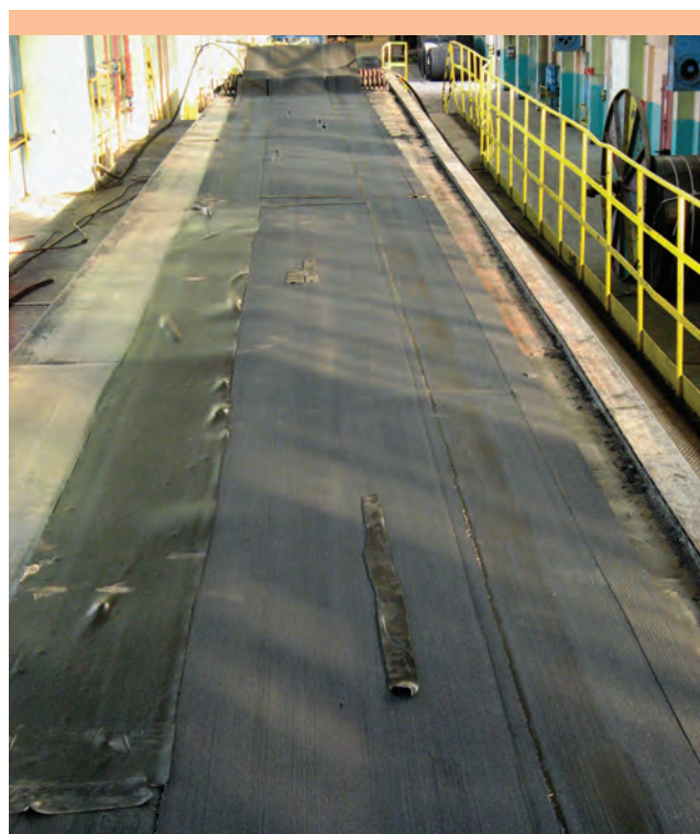
Wyklejanie ubytków w trakcie konfekcji.
