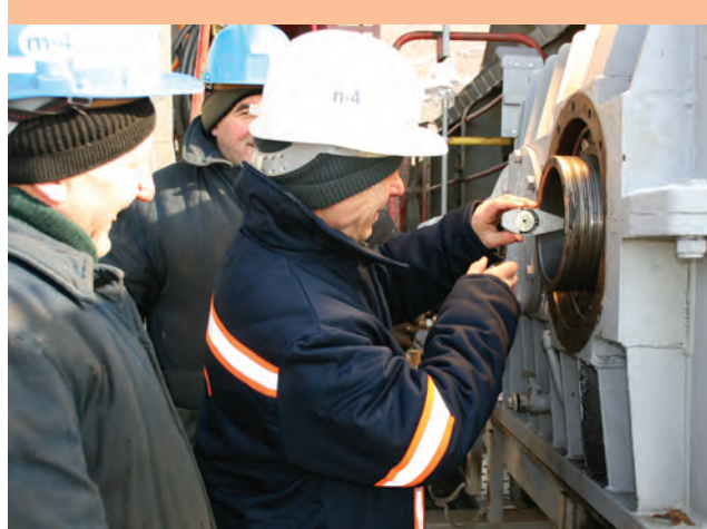
Pomiary przekładni przed montażem podczas remontu koparki K-44 – Tadeusz Kobylarz, pomiarowy na odkrywce.
