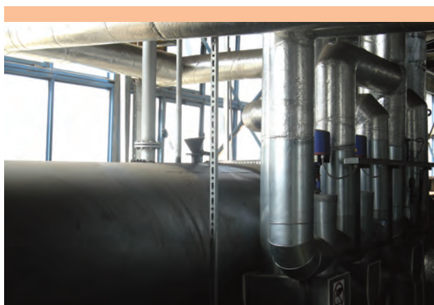
Instalacja grzewcza prasy.
