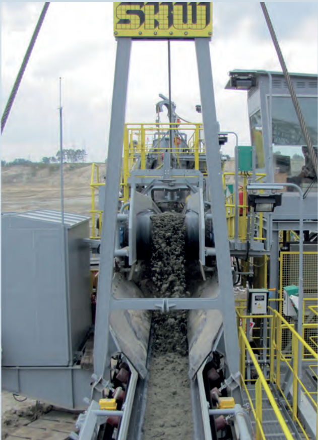
KWK-250L i PGOT-1250.38 pracujące w KWB „Konin” na odkrywce „Tomisławice”, lej koła czerpakowego KWK (z lewej) i przesyp centralny PGOT-a.
