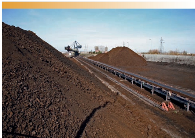
Plac składowy węgla przy odkrywce „Józwin”.
