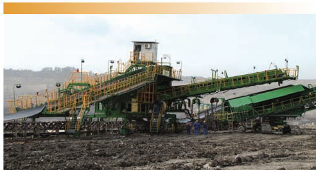
Wózek zrzutowy i przenośnik obrotowy Q_{te}=6.500 \text{ m}^3/\text{h} w KWB Turów.
