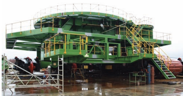
Montaż koparki KWK-1500.1.
