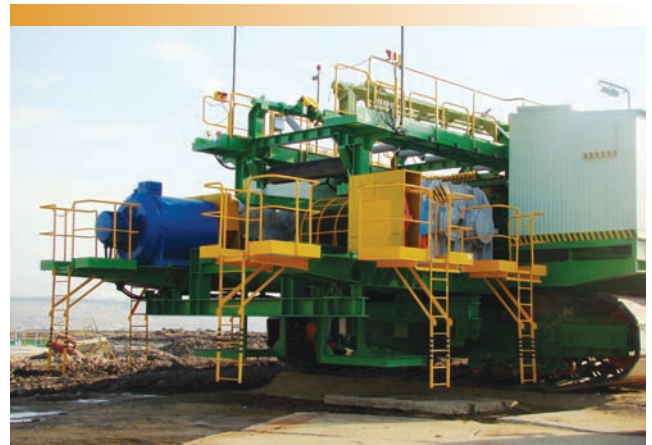
Modernizacja stacji napędowej Z6.6.
