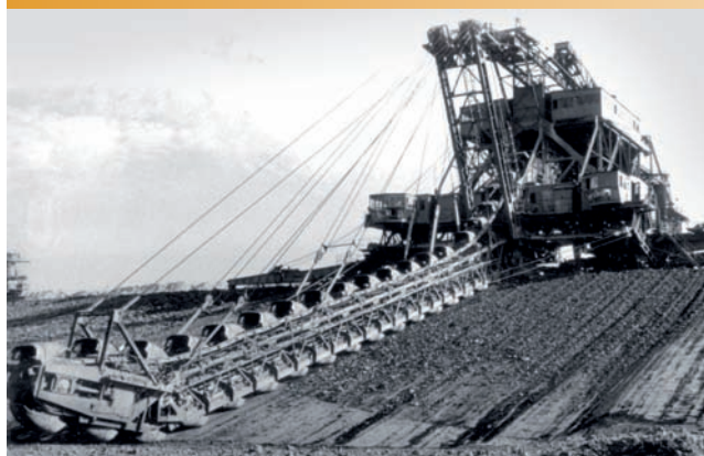
Rys. 13. Koparka tańcuchowa Ds-1120 pracująca w nadkładzie w O/Gostawice [fot. J. Ryguła].
