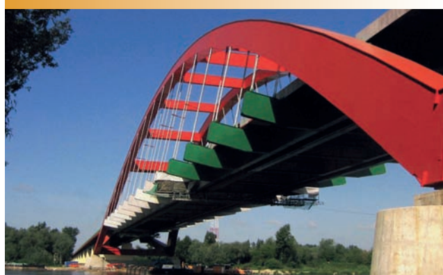
Część łukowa mostu w Puławach.
