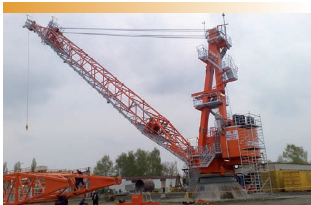
Żuraw kratownicowy na platformę wiertniczą. Montaż w Famak S.A.
