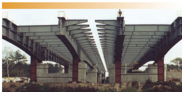
Konstrukcja stalowa mostu przez rzekę Wartę na obwodnicy Poznania (trasa A2).
