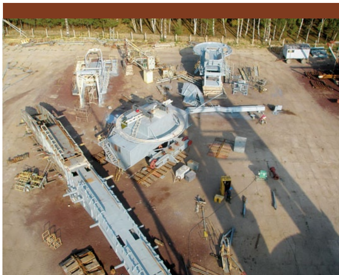
Montaż koparki SRs-1200.
