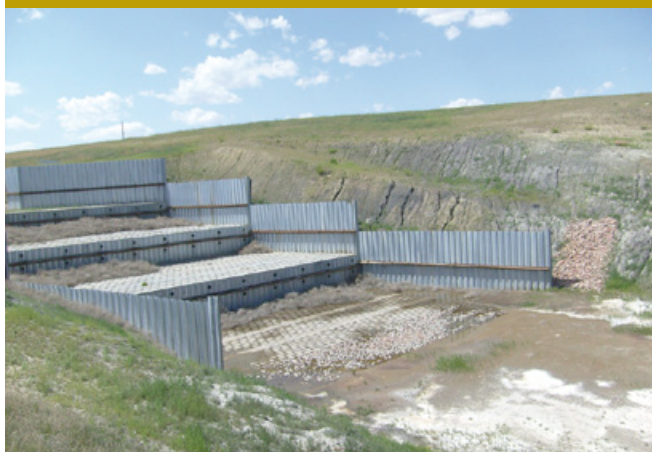
Foto 3. Rekonstrukcja i budowa cieków wodnych – ważny element kształtowania biotopów w fazie rekultywacji technicznej.
