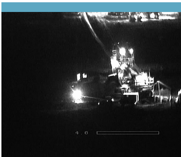
Fot. 1. Stacja przenośnikowa.
