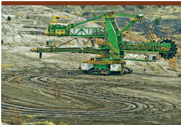
Koparka w trakcie zjazdu z placu montażowego na poziom roboczy – widać wyraźne ślady jazdy po łukach o małym promieniu R=25 m.
