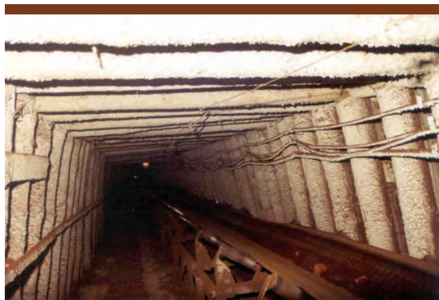
Rys. 5. Przekop łączący S-III i S-IV z transportem taśmowym węgla czynny do 1990 roku w kopalni „Sieniawa”.
