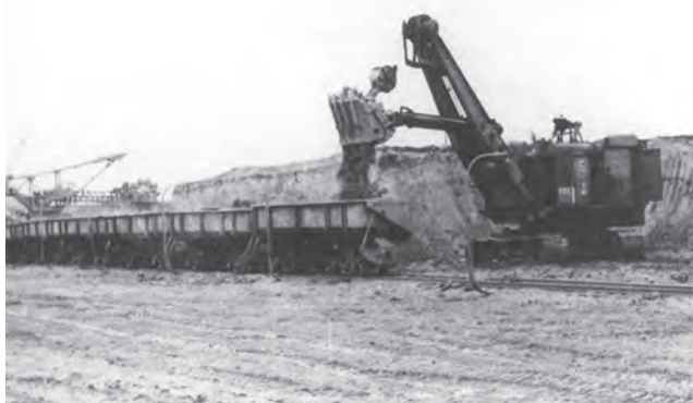
Rys. 2. Koparka jednonaczyniowa pracująca w nadkładzie O/Gosławice.
