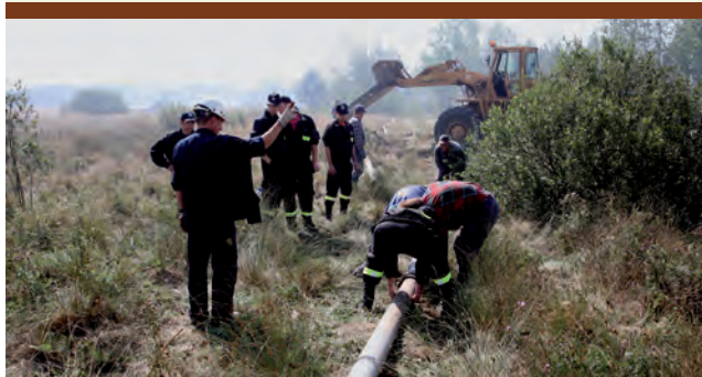
Pracownicy Odkrywki „Drzewce” wraz ze strażakami błyskawicznie zbudowali rurociąg.
