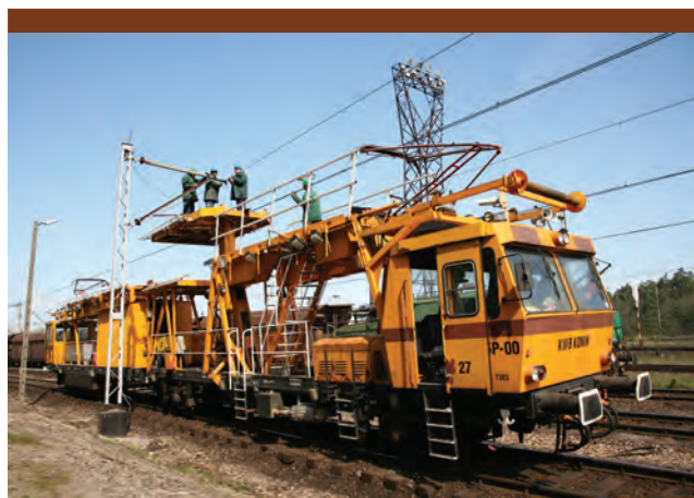
Pociąg sieciowy w czasie prac.
