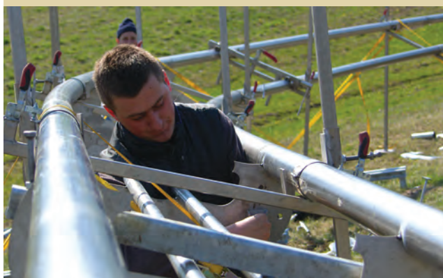
Budowa toru saneczkowego.
