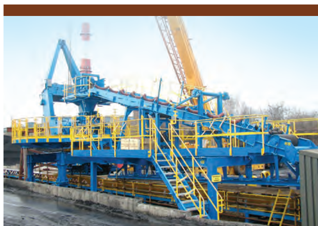
Ładowniko-zwałowarka ŁZKS100.16, ZRE Katowice SA / Elektrociepłownia Będzin SA. Zdjęcie podczas montażu.
