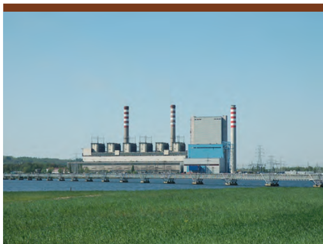
Widok Elektrowni „Pątnów” – rok 2006.
