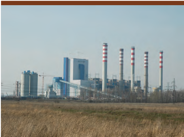
Widok Elektrowni „Pątnów” z budowanym blokiem 464 MW w Elektrowni „Pątnów II” (z lewej strony) i wybudowanymi dodatkowo dwoma kominami do instalacji odsiarczania spalin w Elektrowni „Pątnów I”.
