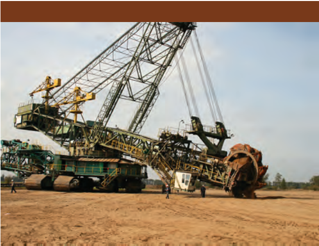
Początek zdejmowania nadkładu w polu centralnym Odkrywki „Kozmin”.
