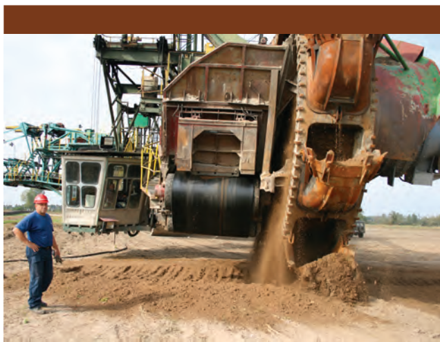
Początek zdejmowania nadkładu w polu centralnym Odkrywki „Koźmin”.
