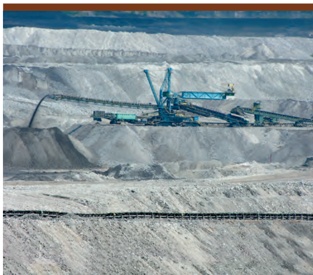
Zwałowarka Z-45 na froncie północnym zwałowiska wewnętrznego.
