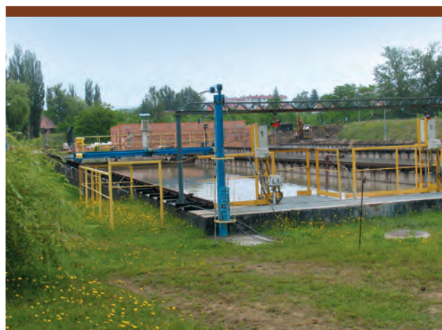
Modernizowana oczyszczalnia nad Potokiem Ślad.
