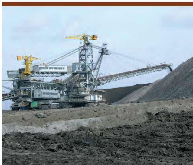
Koniec formowania ostatniego piętra zwałowego na zwałowisku zewnętrznym przez Z-42.
