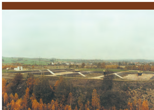
Rys. 2. Widok oczyszczalni wód kopalnianych nad Nysą Łużycką.
