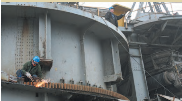
Odkrywka „Józwin” – remont koparki.
