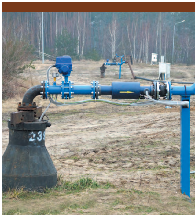
Rys. 2. Studnie bariery ochronnej.
