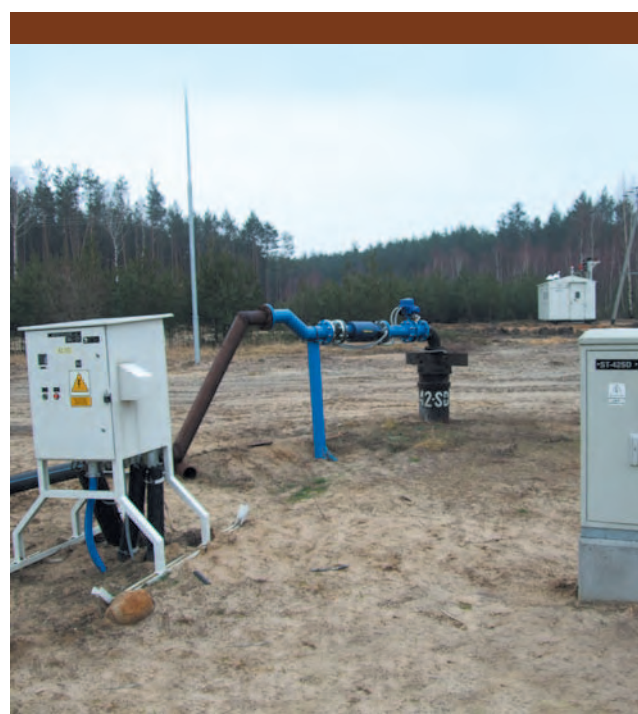
Rys. 3. Zautomatyzowana studnia bariery.
