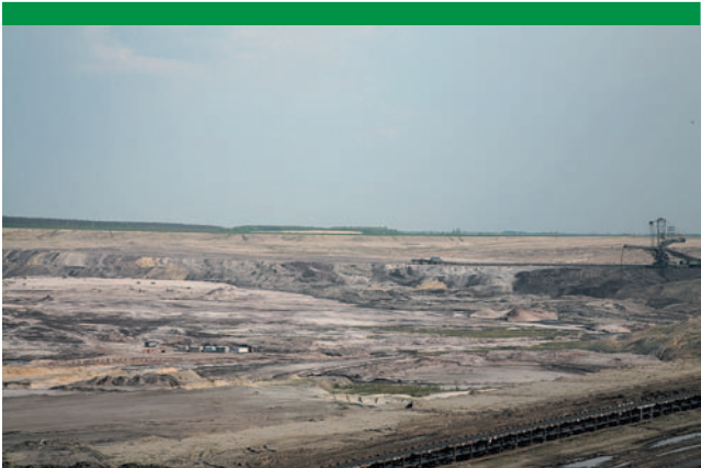
Rys. 4. Odkrywka „Lubstów” – kształtowanie południowej skarpy zbiornika końcowego.
