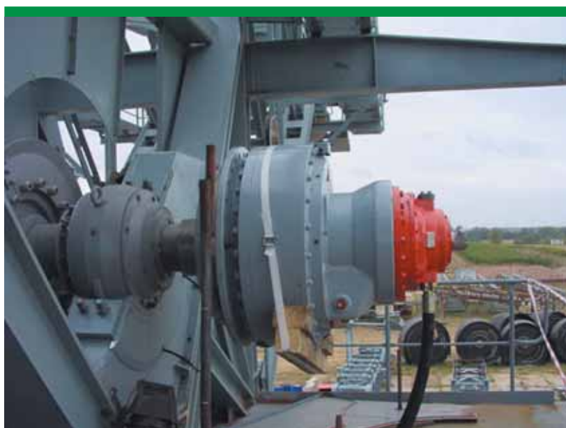
Przekładnia pośrednia i silnik hydrauliczny w czasie montażu.
