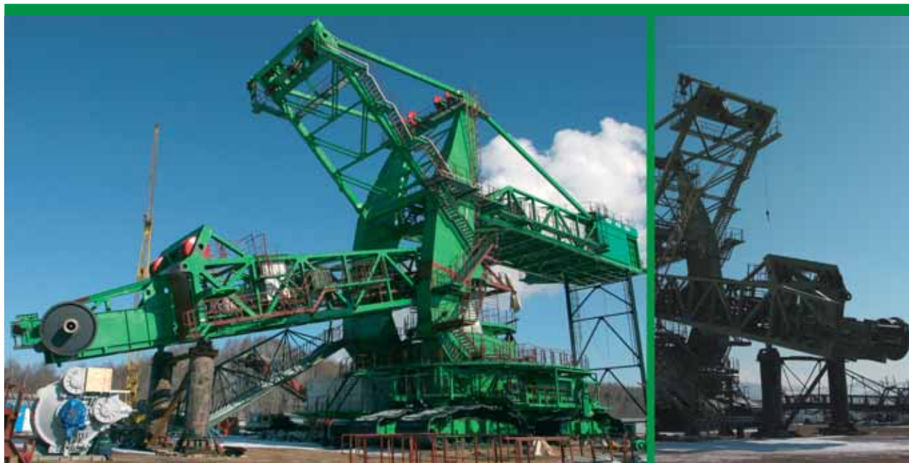
Na placu montażowym BOT Kopalni Węgla Brunatnego Turów SA powstaje nowa koparka kołowa do urabiania utworów trudnourabialnych o symbolu KWK-910.
