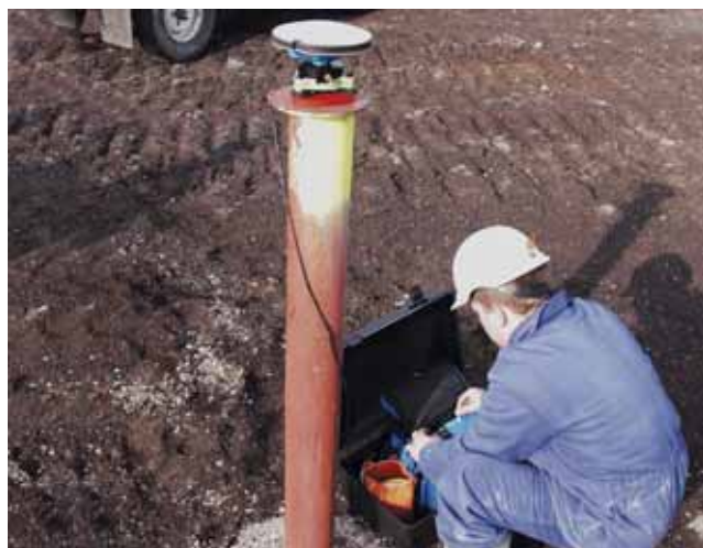
Pomiar geodezyjny punktu bazowego sieci obserwacyjnej z wykorzystaniem technologii pomiarów satelitarnych (GPS).
