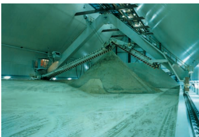
Ładowarka portalowa w magazynie gipsu BOT ELEKTROWNIA OPOLE SA.
