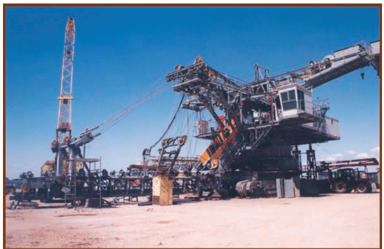
Prace modernizacyjne przy koparce Rs-400.
