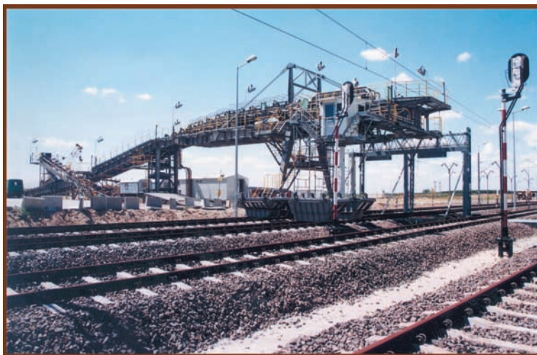
Przebudowana i zmodernizowana załadownia węgla odkrywki „Drzewce”.
