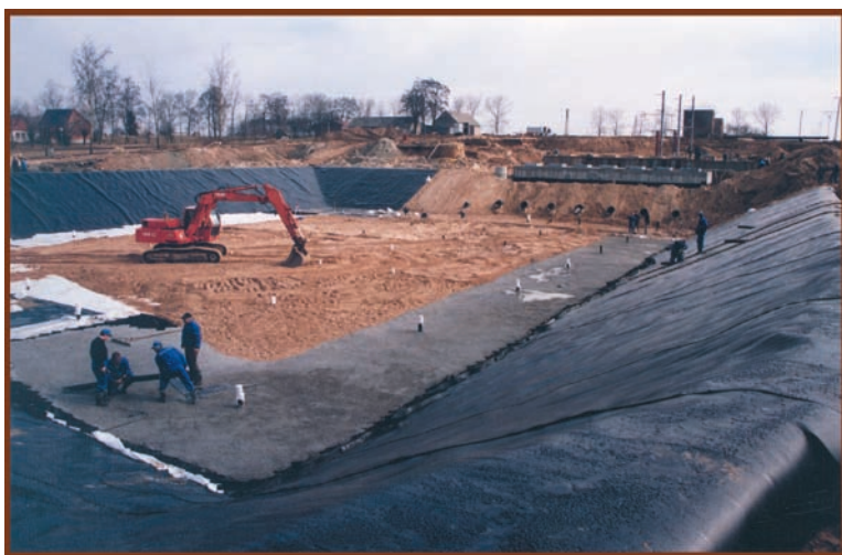
Budowa pompowni Pp1.
