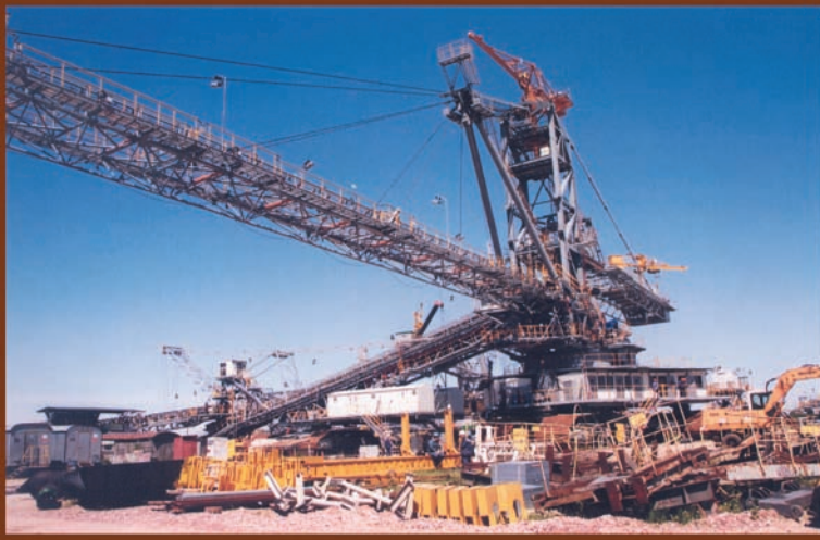
Końcowe roboty modernizacyjne przy zwałowarce A 2 RsB-5000M.
