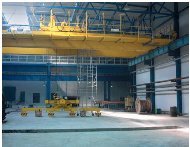
Suwnica pomostowa z trawersą magnetyczną do transportu blach – Rosja.
