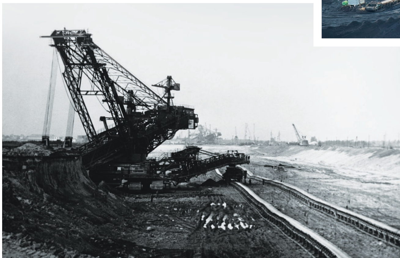
Wkop otwierający odkrywki Adamów, rok 1962. (fot. archiwum)
