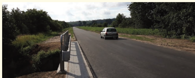
Wyremontowana droga od strony Komorowa.
