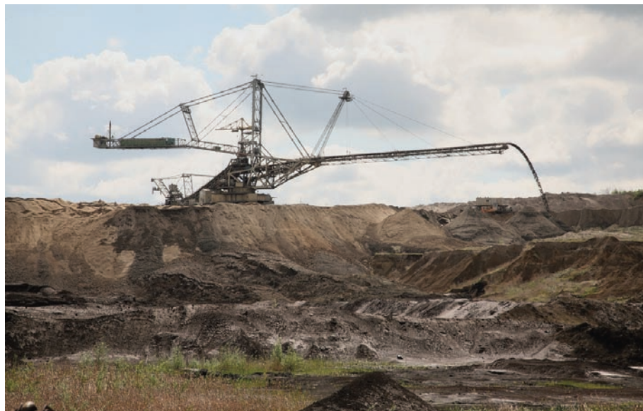
Zwałowarka A 2 RsB-8800 kształtuje skarpy przyszłego zbiornika końcowego odkrywki Józwin.
