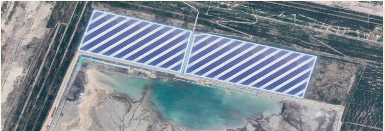
Teren pod budowę farmy PV.
