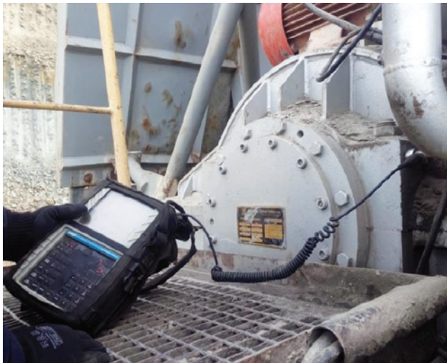
Fot. 16. Badanie wibroakustyczne przekładni głównej koła czerpakowego koparki SRs 1200/1.
