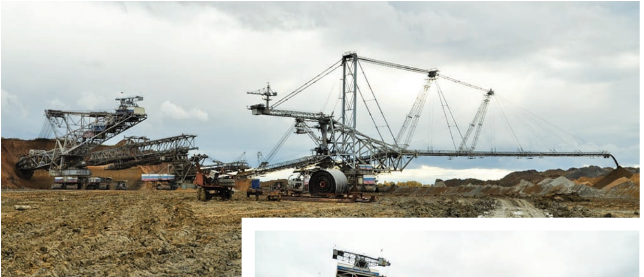
Rys. 12. Koparka SRsK-4000 (Takraf) w układzie bezpośrednim ze zwalówarką.
