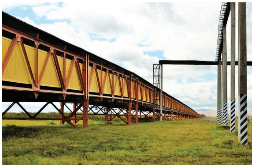
Rys. 11. Przenośnik kryty z węglem brunatnym transportowanym do elektrowni.
