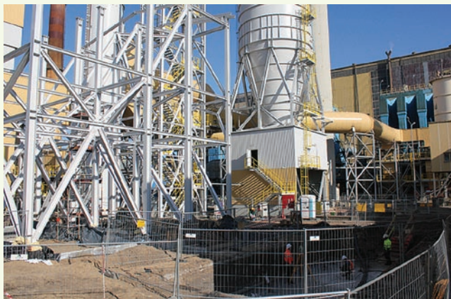
Rozbudowa instalacji odsiarczania spalin.
