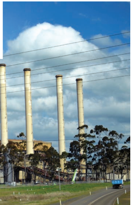
Elektrownia Hazelwood o mocy 8x220 MW zamknięta w 2017 roku.
