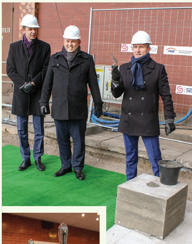
Murowanie kamieni węglanych.
