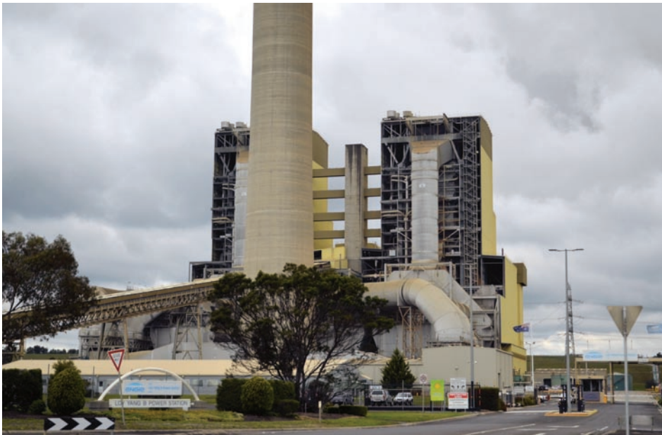
Elektrownia Loy Yang B o mocy 2 x 513 MW.
