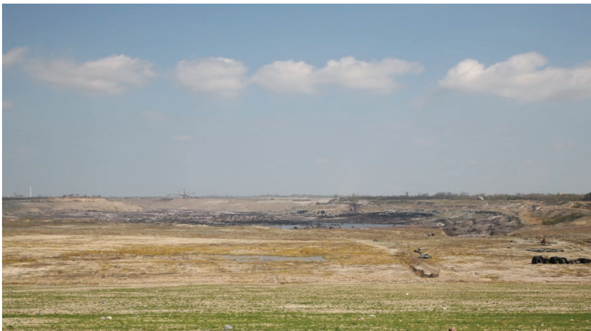
Rok 2011 – na pierwszym planie rekultywowana skarpa południowa zbiornika, w tle ostatnie maszyny pracujące na odkrywce.
