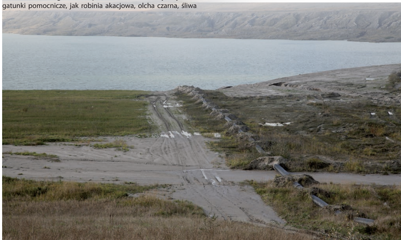
Rurociąg doprowadzający wodę ze Strugi Kleczewskiej (listopad 2017).
